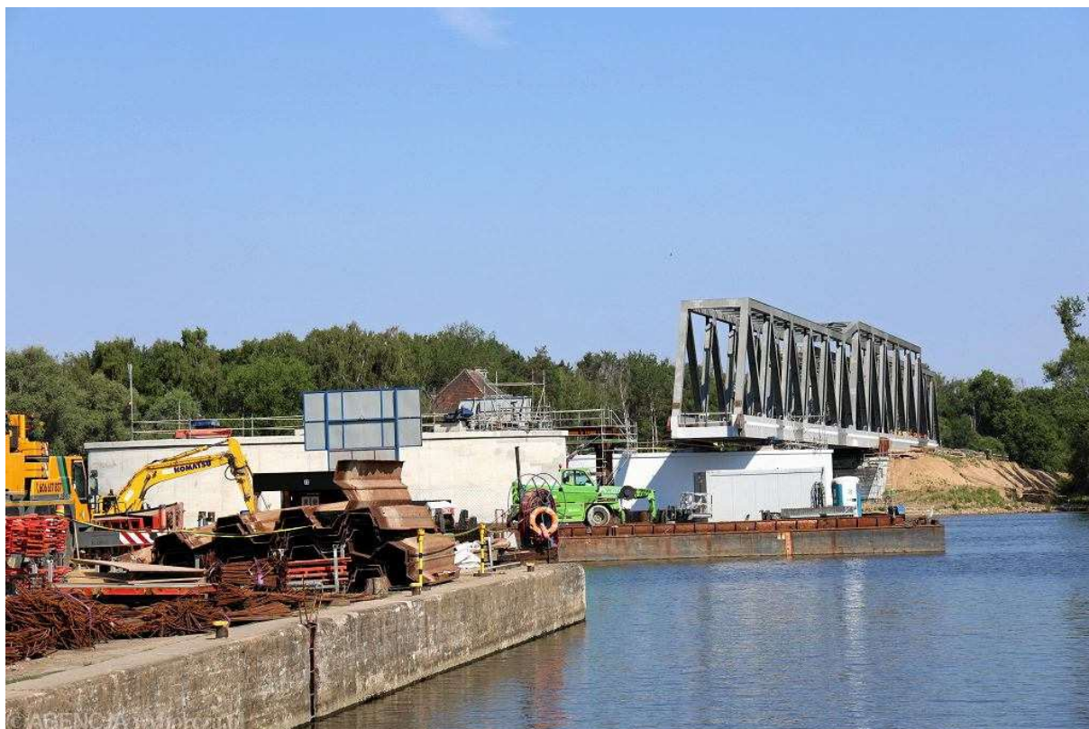
Budowa mostu kolejowego nad rzeką Regalica na trasie Szczecin - Gryfino. Widok od strony Podjuch Fot. Cezary Aszkielowicz / Agencja Wyborcza.pl
