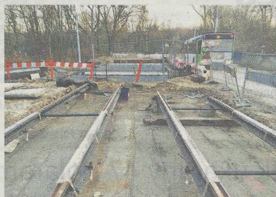
Teraz autobusy przeciskają się przez plac budowy po tej części starego wiaduktu, który też wkrótce zostanie wyburzony. Fot. Mirosław WINCONEK
