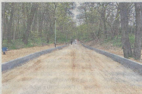
Ulica Międzyparkowa w remoncie. Tędy od pierwszych dni maja br. na czas budowy nowego wiaduktu w ul. Arkońskiej mają kursować miejskie autobusy linii 80. Fot. Mirosław WINCONEK
