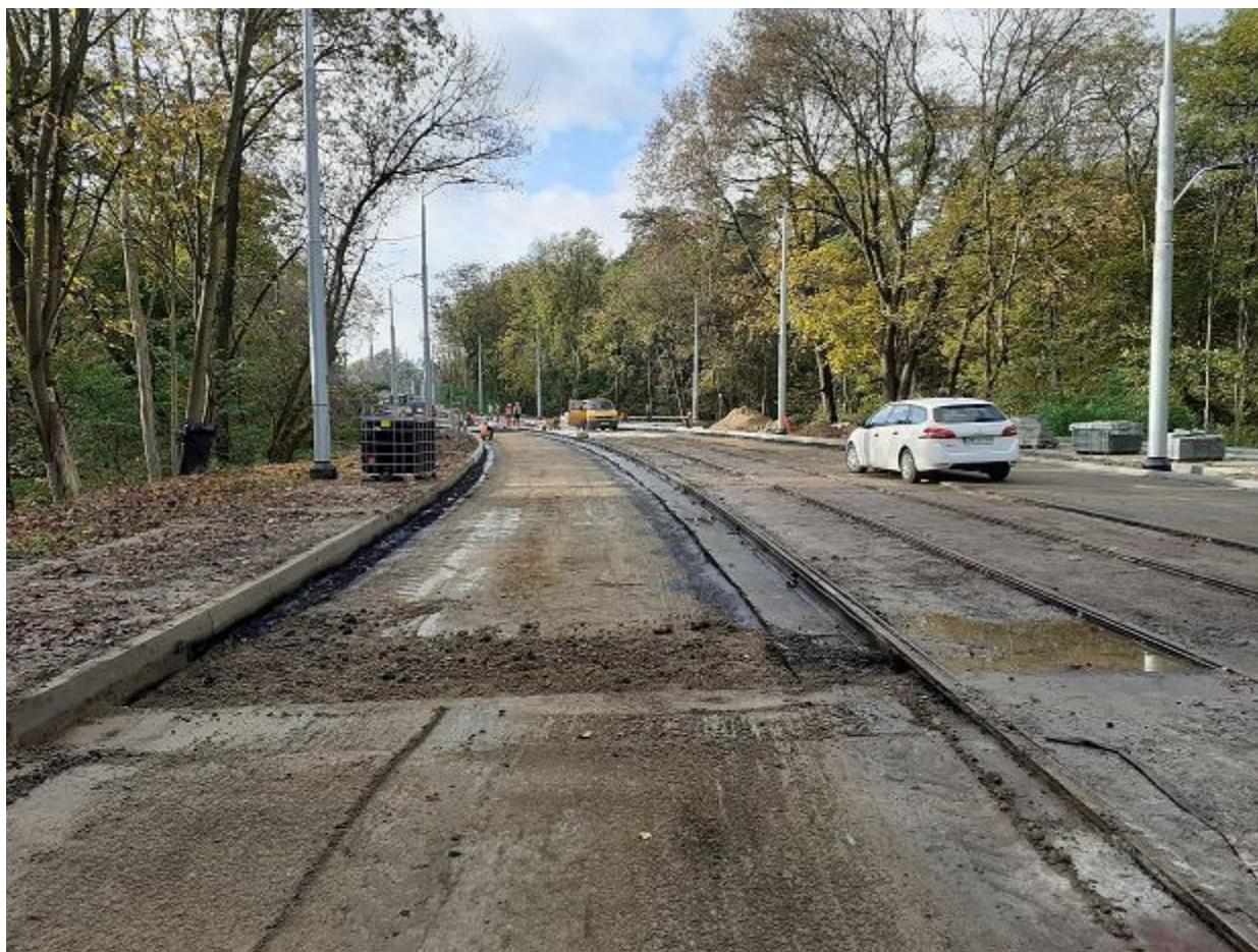
Finale przebudowy ulicy Arkońskiej. Rejon wiaduktu Andrzej Kraśnicki jr
