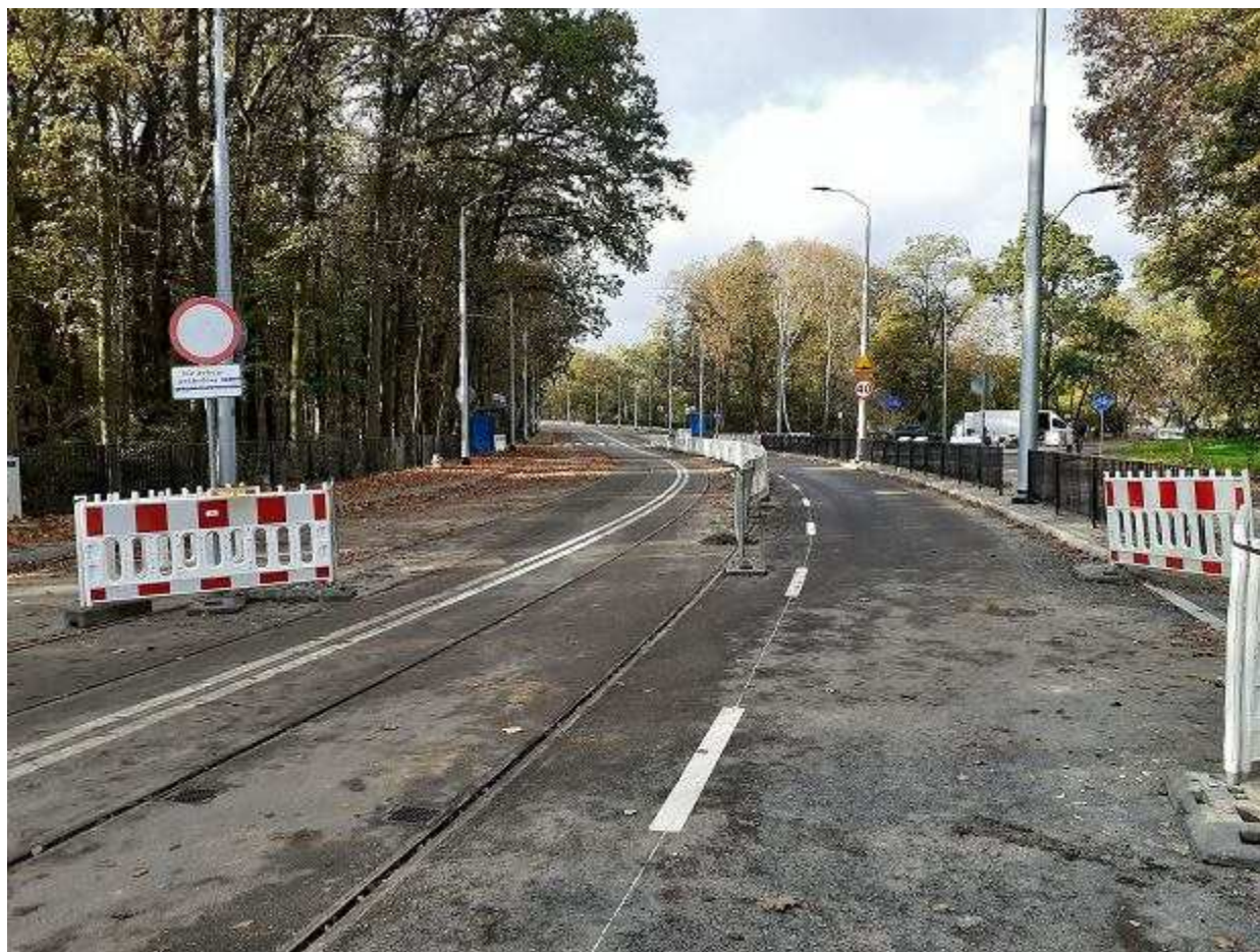
Finał przebudowy ulicy Arkońskiej. Koniec października 2019 Andrzej Kraśnicki jr
