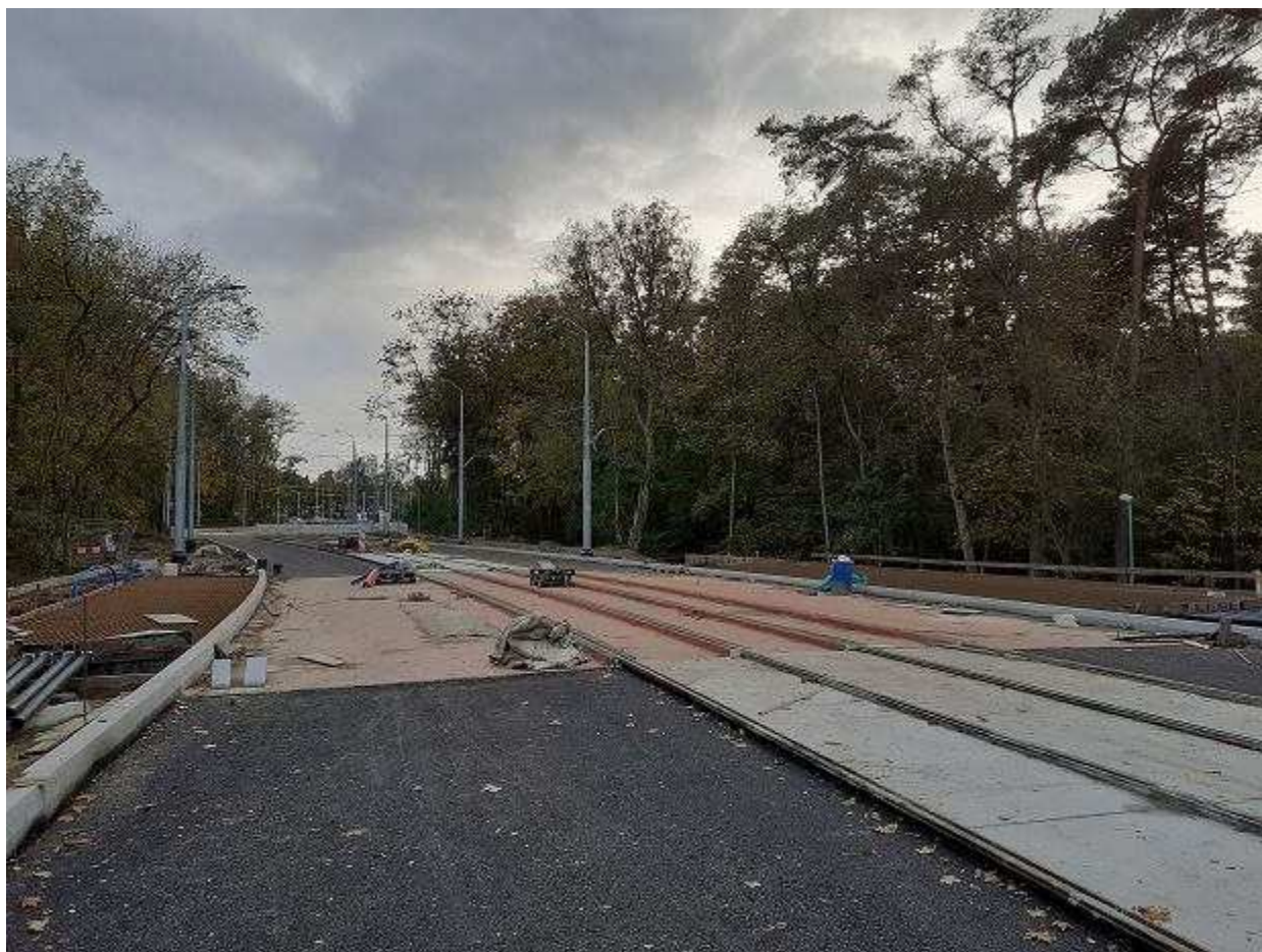
Finał przebudowy ulicy Arkońskiej. Prace przy wiadukcie Andrzej Kraśnicki jr
