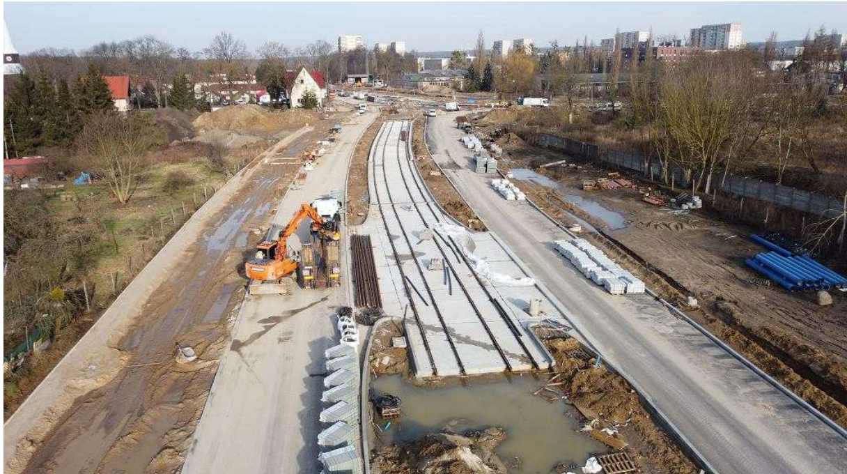
Budowa nowego odcinka ulicy Sosabowskiego. Ślepy odcinek torów prowadzących od strony ul. Żołnierskiej fot. Andrzej Kraśnicki jr
