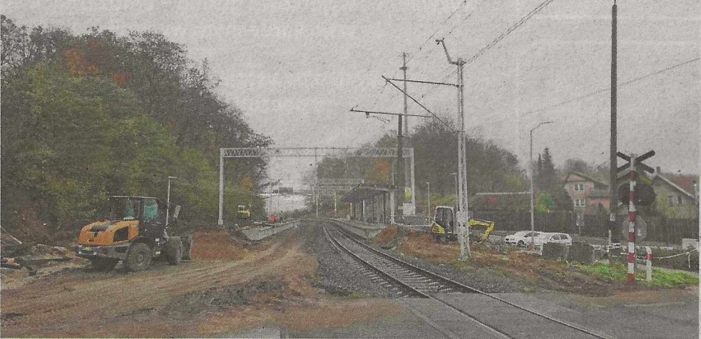
Szczecin Gołębino. Trwają prace przy układaniu drugiego toru linii kolejowej nr 406
