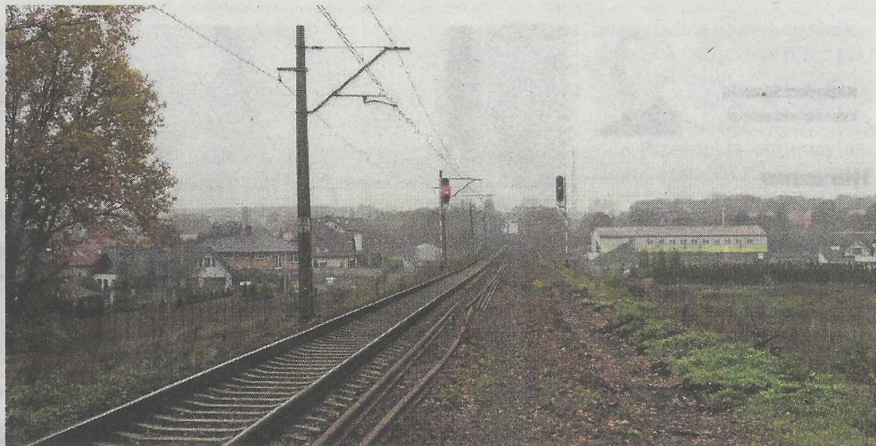
Nowe szyny czekają na montaż. PKP PLK przyznaje, że na bieżąco monitoruje postęp prac
