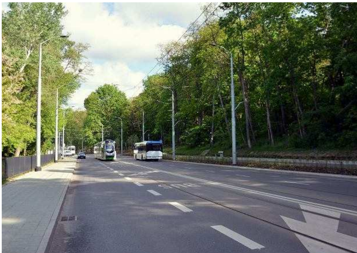
Jazda testowa tramwaju na nowym torowisku zmodernizowanego odcinka ul. Arkońskiej Dariusz Wołoszczuk/ZDiTM
