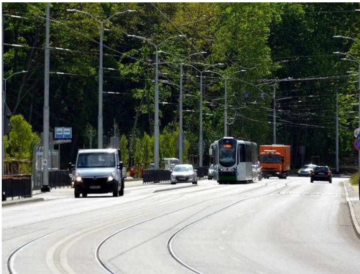
Jazda testowa tramwaju na nowym torowisku zmodernizowanego odcinka ul. Arkońskiej Dariusz Wołoszczuk/ZDiTM
