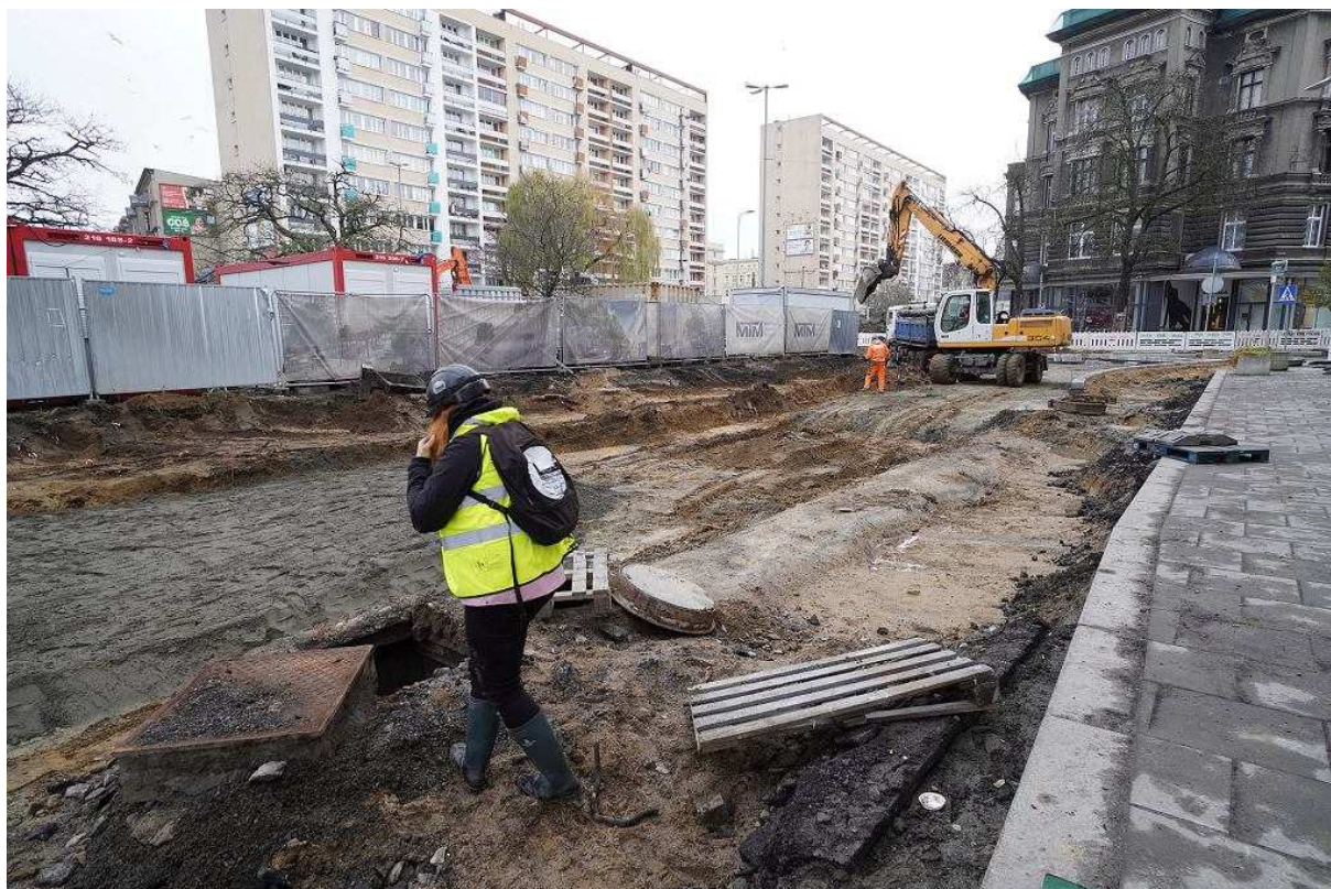
Pl. Zgody. Widać sklepienie zbiornika przeciwpożarowego Fot. Andrzej Kraśnicki jr
