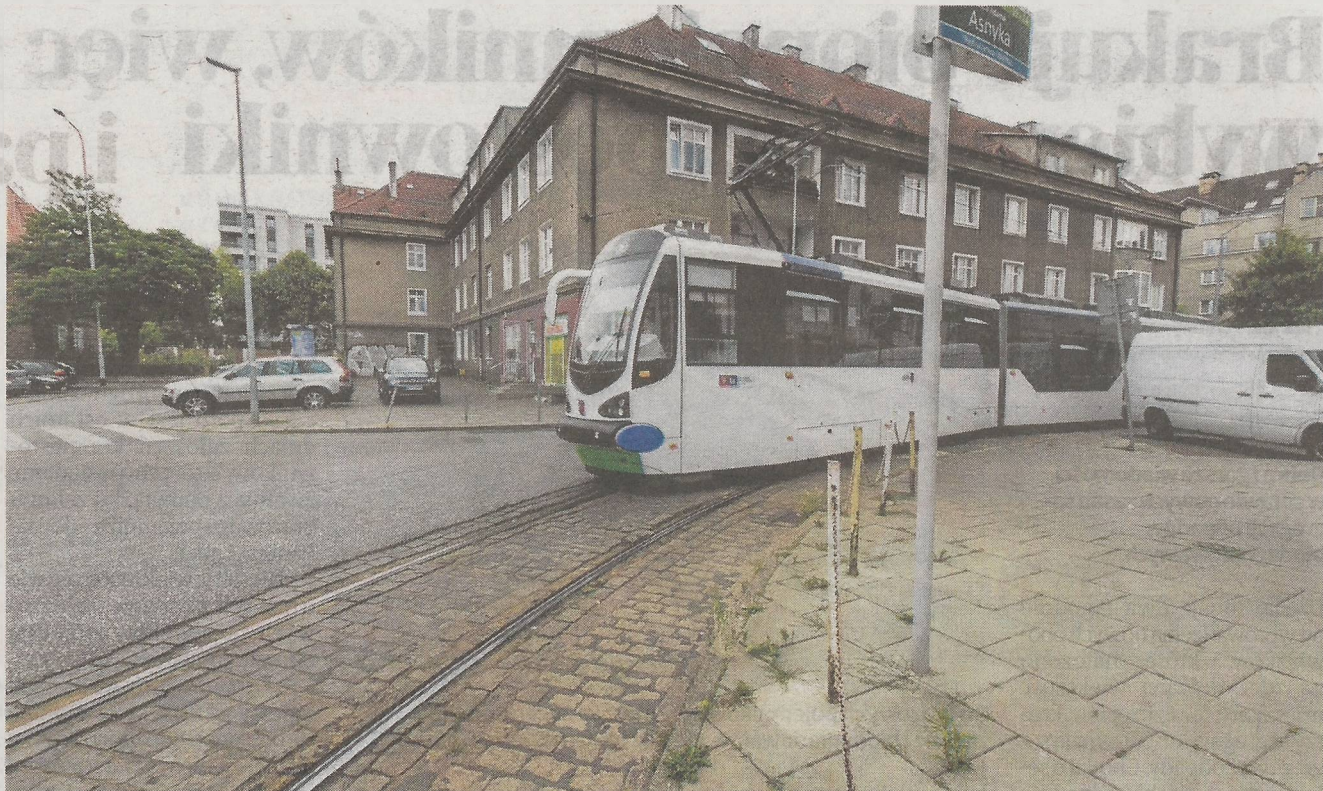
Smarownica zmniejsza charakterystyczny dźwięk, który powstaje przy skręcaniu tramwajów, a tory zużywają się dużo wolniej
