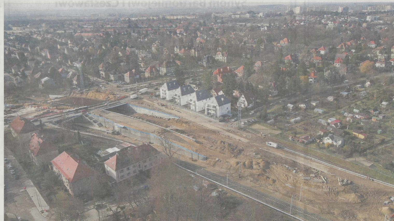
Widok z drona na plac przebudowy węzła Łękno i postępy prac przy budowie powiązanego z nim odcinka trasy średnicowej, która bieć będzie obrzeżami Pogodna.
