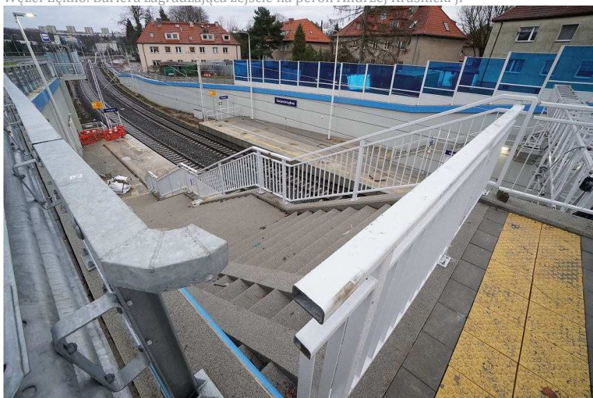
Węzeł Łęčno. Bariera zagrażająca zejście na peron Andrzej Kraśnicki jr
