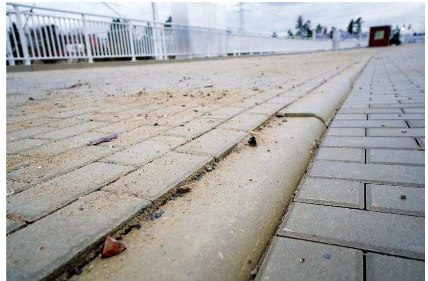
Węzeł Łęčno. Byle jak ułożona nawierzchnia parkingu Andrzej Kraśnicki jr
