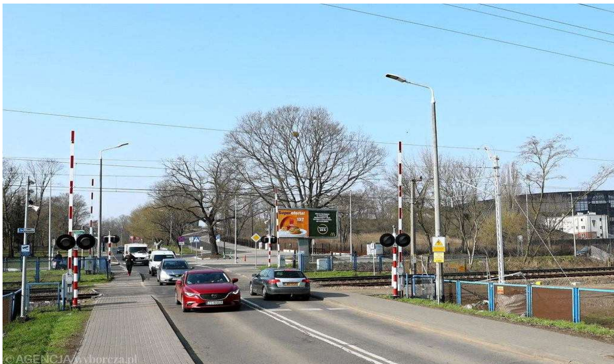
Przejazd kolejowy w ciągu ulicy Jagiellońskiej. Miasto zabiega o dofinansowanie budowy wiaduktu nad torami Fot. Cezary Aszkiełowicz / Agencja Wyborcza.pl
