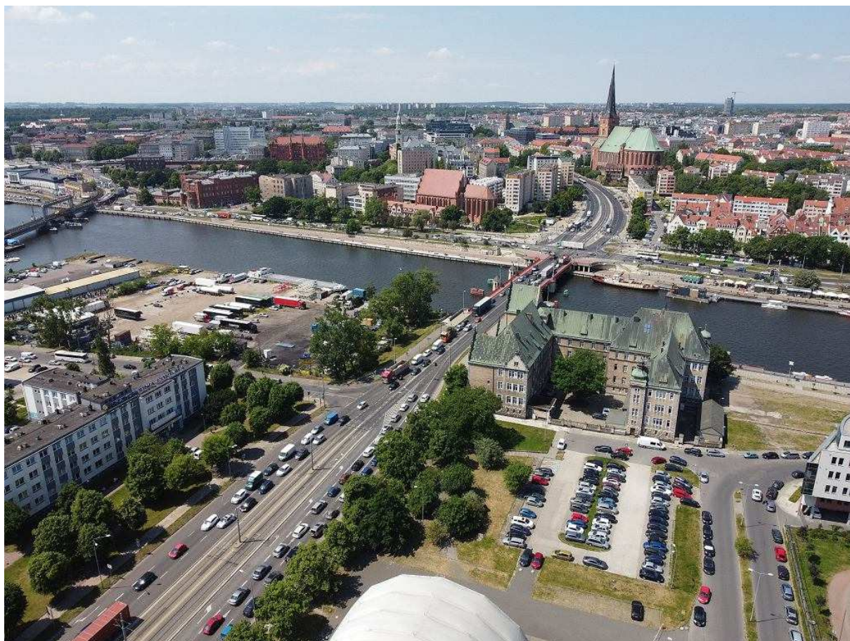
Widok na nadodrzańską część ul. Energetyków i bulwary Łasztowni Andrzej Kraśnicki jr
