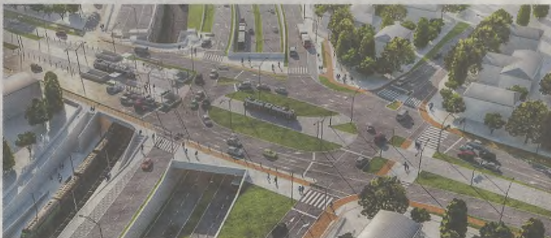
Węzeł komunikacyjny Łękno to kluczowy punkt powstającej Trasy Średnicowej i Szczecińskiej Kolei Metropolitalnej.
