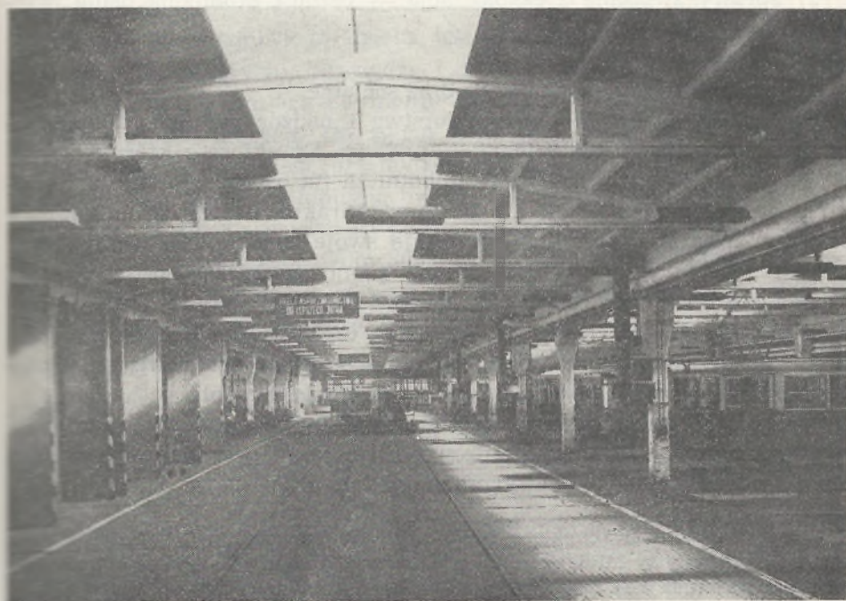
Ryc. 15. Centralne Warsztaty — wnętrze
