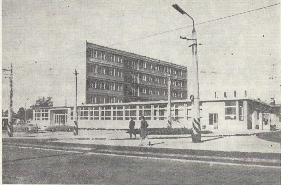
Ryc. 7. Obecny budynek dyrekcji od 1968 r. przy ul. Klonowica
