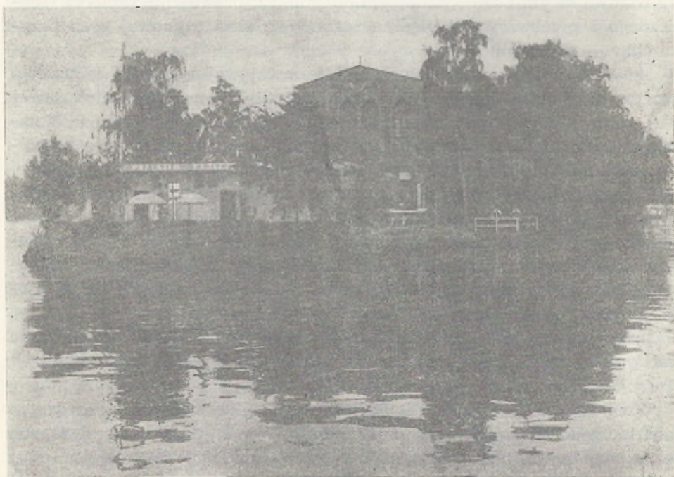
Ryc. 18. Przystań kajakowa pracowników MPK na Wyspie Jaskółczej przy ul. Kolumba
