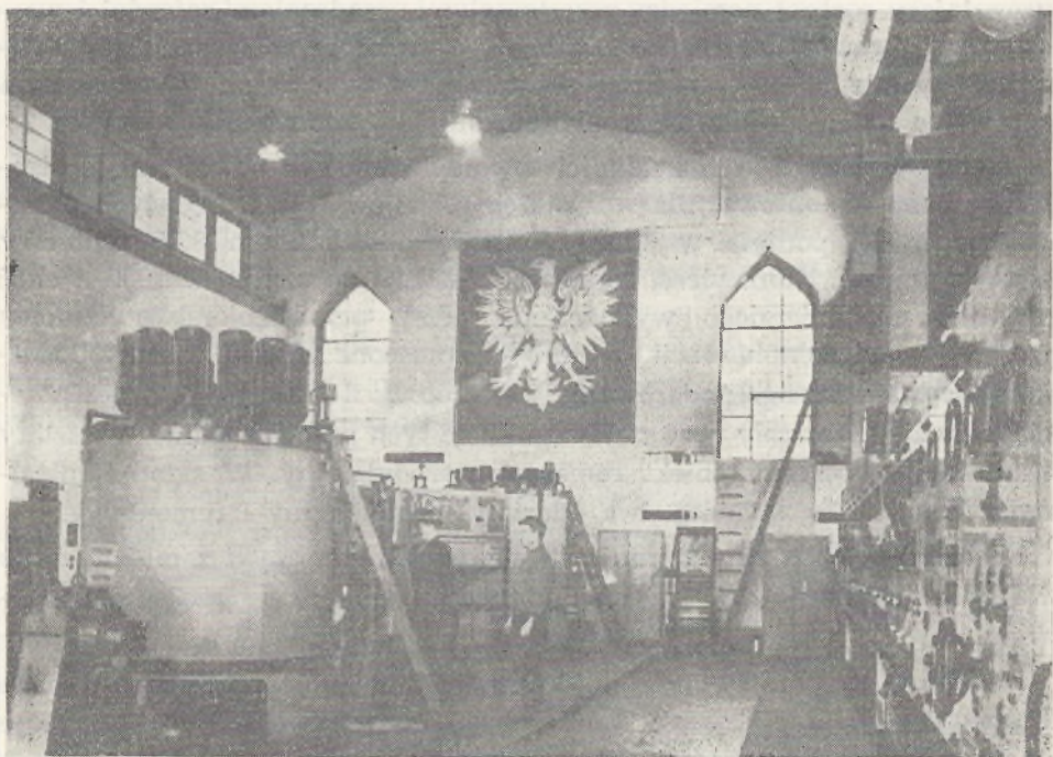
Ryc. 12. Wnętrze odbudowanej stacji prostowniczej przy ul. Krzysztofa Kolumba
