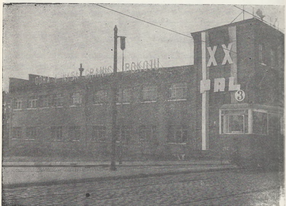
Ryc. 5. Budynek dyrekcji w latach 1946—1968 przy ul. K. Kolumba
